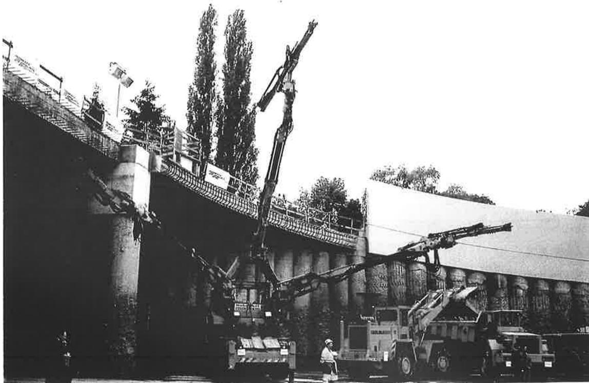
Visite de l'amorce du tunnel de Soumagne : vue d'un robot de forage avec trois bras destinés à préparer le placement des explosifs. Chênée, le 14/09/02 (Photo G.B.)
